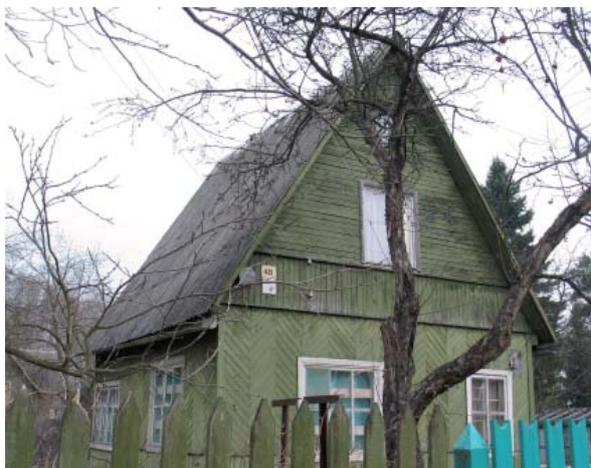
Рисунок 3. Обшивка стен «елочкой»
