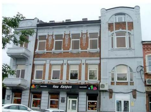
Рисунок 8. Изменение облика за счёт покраски и замены оконных и дверных конструкций
