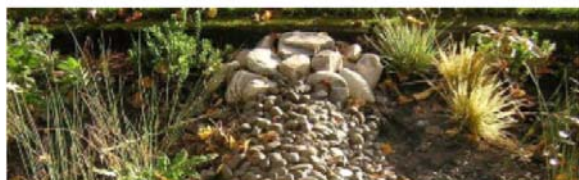
Рисунок 2. Управление ливневым стоком на северо-восточной улице Сискию (Siskiyou), Портленд, США. Озелененная разделительная полоса между автомобильным и пешеходным движением, поглощающая дождевую воду, помогает снизить нагрузку на ливневые коллекторы [10]
